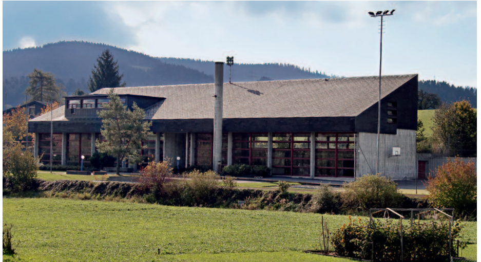
Die notwendige Sanierung der Turnhalle in Zäziwil brachte die strategische Immobilienplanung der Gemeinde ins Rollen.
